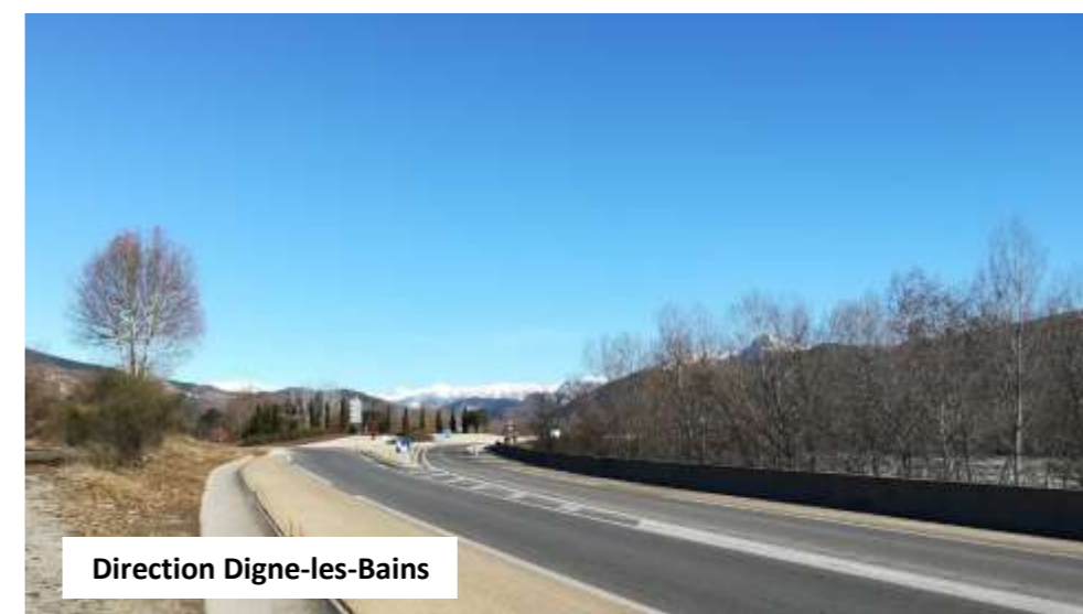
Figure 1. Topographie de l'aire d'étude, vue depuis la RN85
