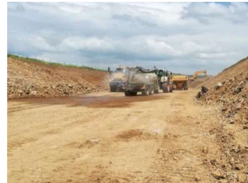
Arrosage des pistes de chantier
