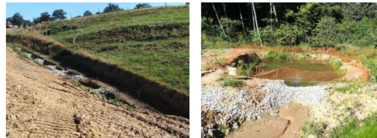
Fossés provisoires et bassin de rétention des particules fines en phase de travaux
