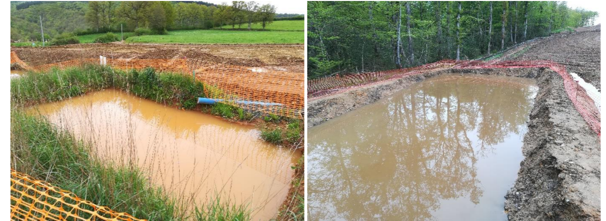
Exemples de bassin provisoire
