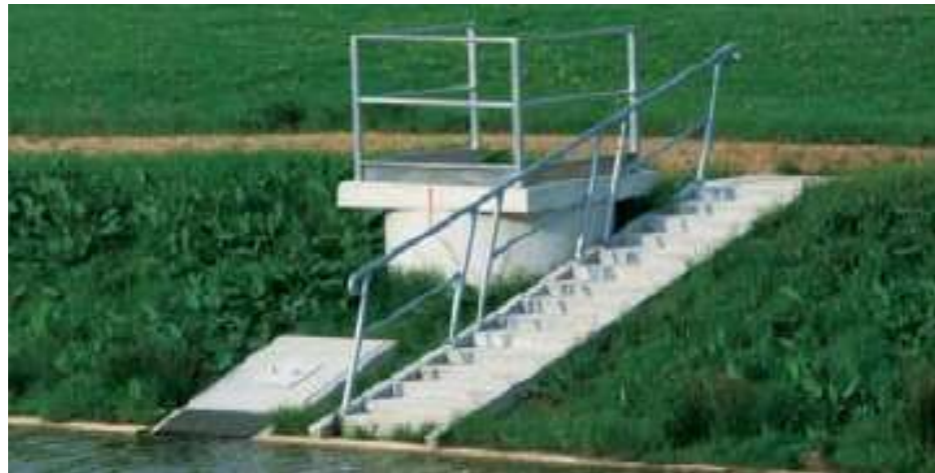
Figure 11 : Exemple ouvrage de sortie
