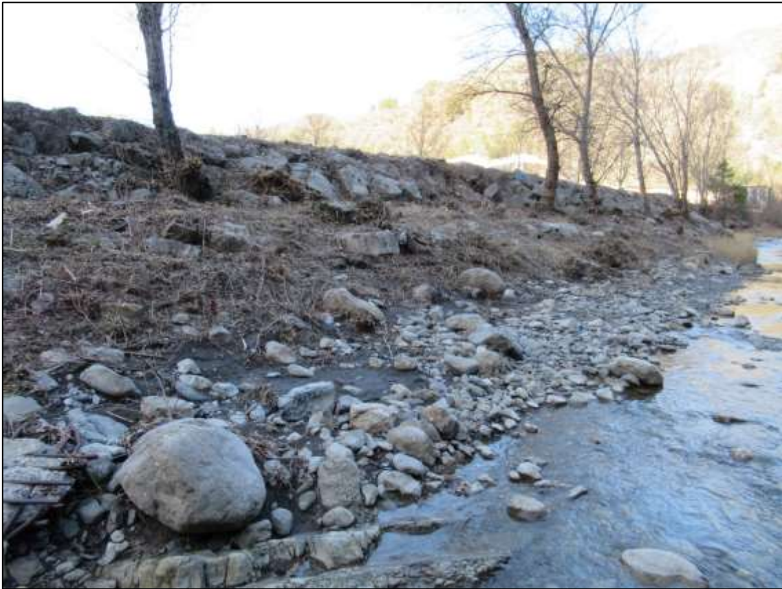
Figure 11 : Parement côté torrent du tronçon C
