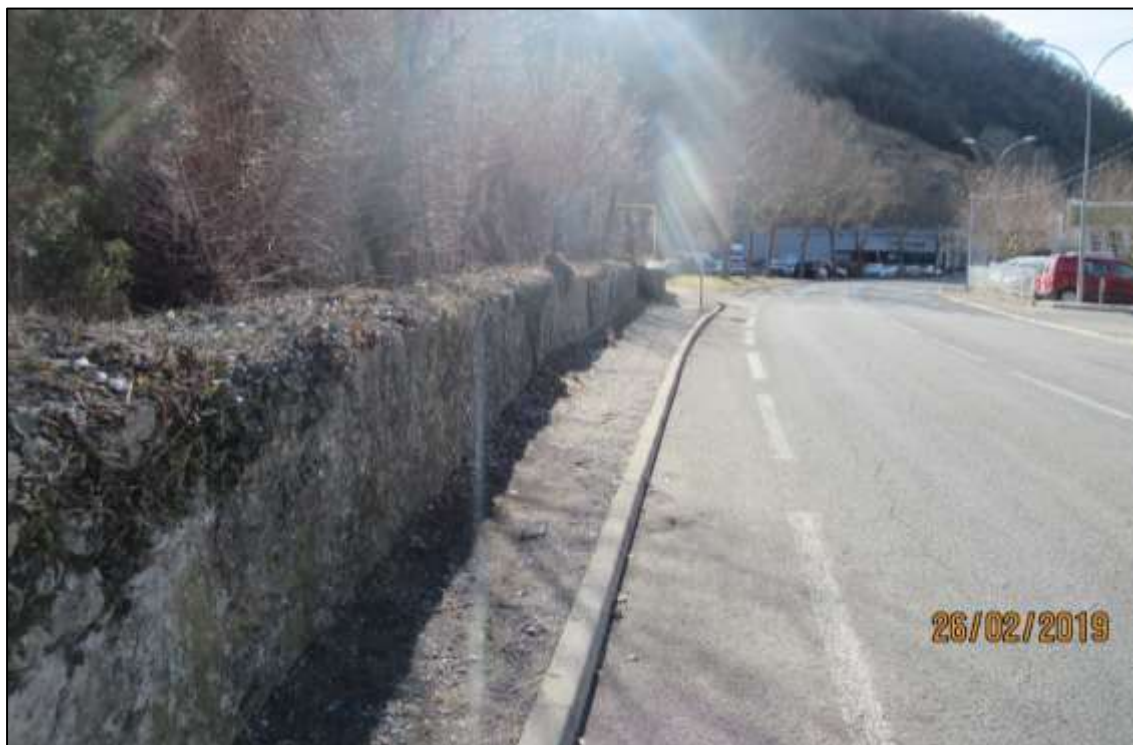
Figure 5 : Vue vers l'aval, le mur maçonné longeant la route
