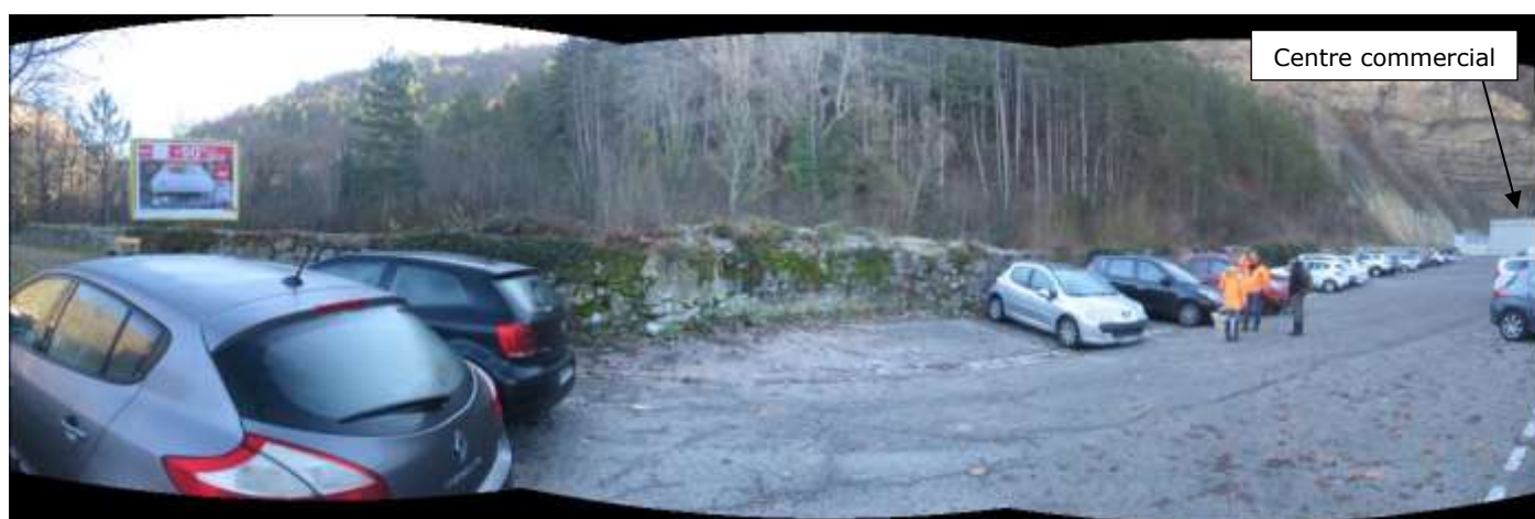
Figure 17 : Vue du secteur à conforter côté terre
