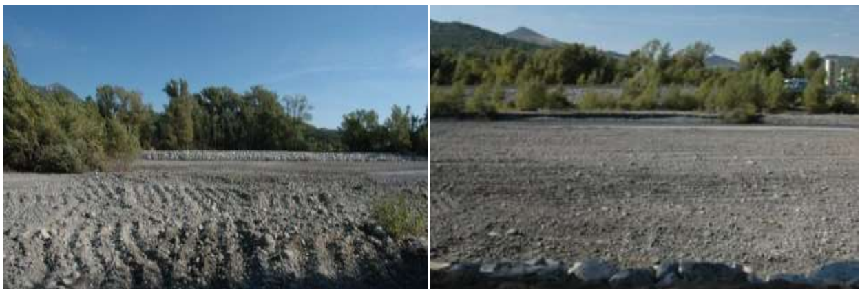
Lit de la Bléone remis en état suite au chantier de confortement de berge au lieu-dit Valadier à Digne (SYNDICAT MIXTE ASSE BLÉONE, 2012)
