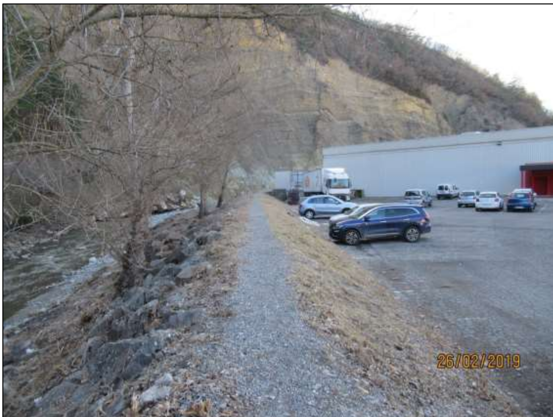
Figure 9 : Vue du tronçon C prise depuis la crête, vers l'aval
