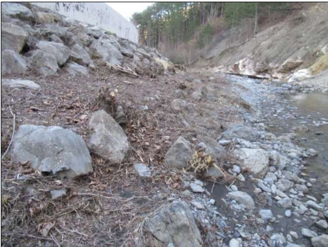
Figure 14 : Vue vers l'amont du tronçon B
