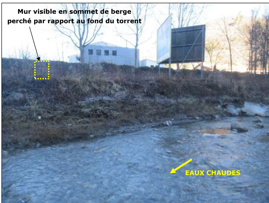
Figure 6 : Décalage altimétrique entre le lit et le mur de pierres
