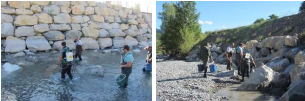
Pêche de sauvetage avant travaux – Chantier de confortement de la digue des Epinettes (SYNDICAT MIXTE ASSE BLÉONE, 2012)
