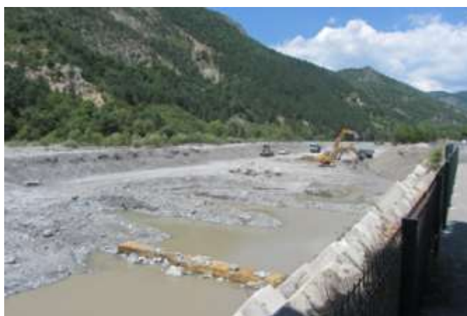
Exemple de bassin mis en place lors des travaux de confortement de la digue des Epinettes amont à Digne les Bains en 2013 (photo SYNDICAT MIXTE ASSE BLÉONE)
