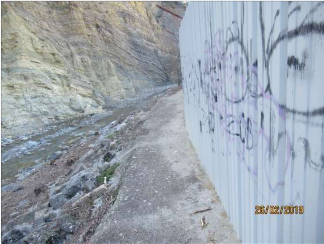
Figure 13 : Vue vers l'aval du tronçon B
