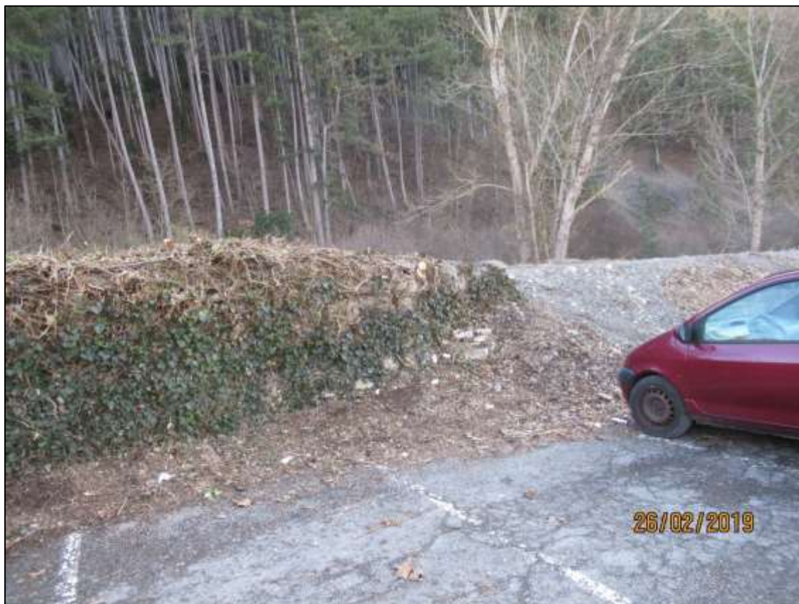
Figure 7 : Limite aval du mur (tronçon D) et limite amont de la digue de 1992 (tronçon C) – vue côté terre
