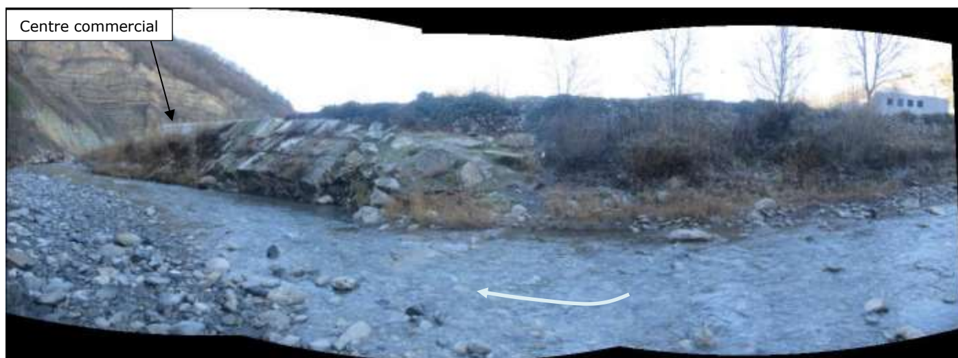
Figure 18 : Vue du secteur à conforter côté torrent
