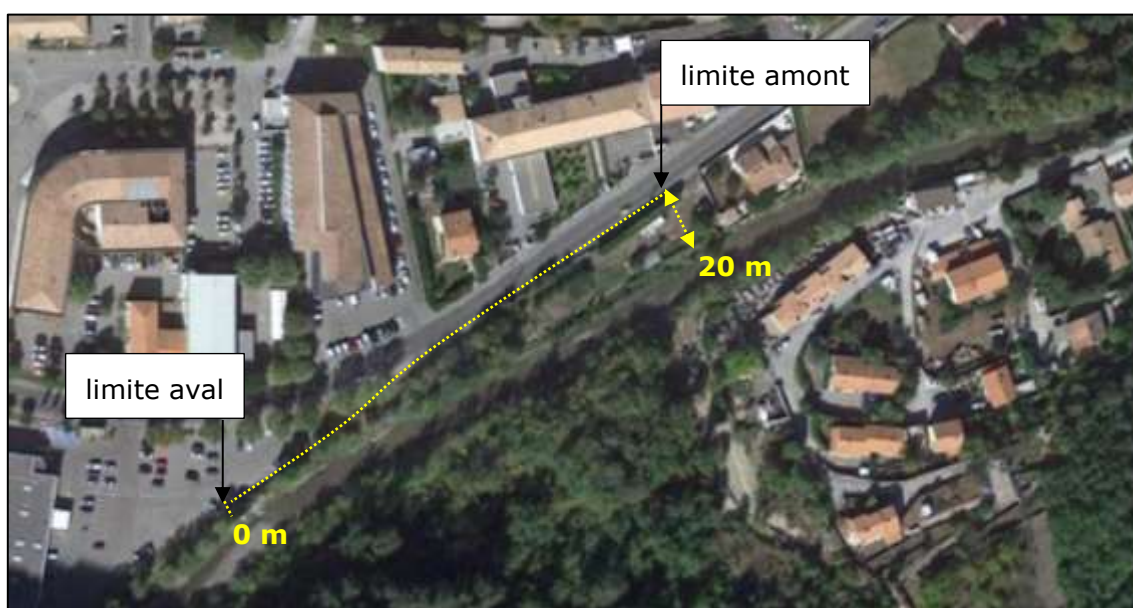
Figure 4 : Vue aérienne du tronçon D - mur en pierres
