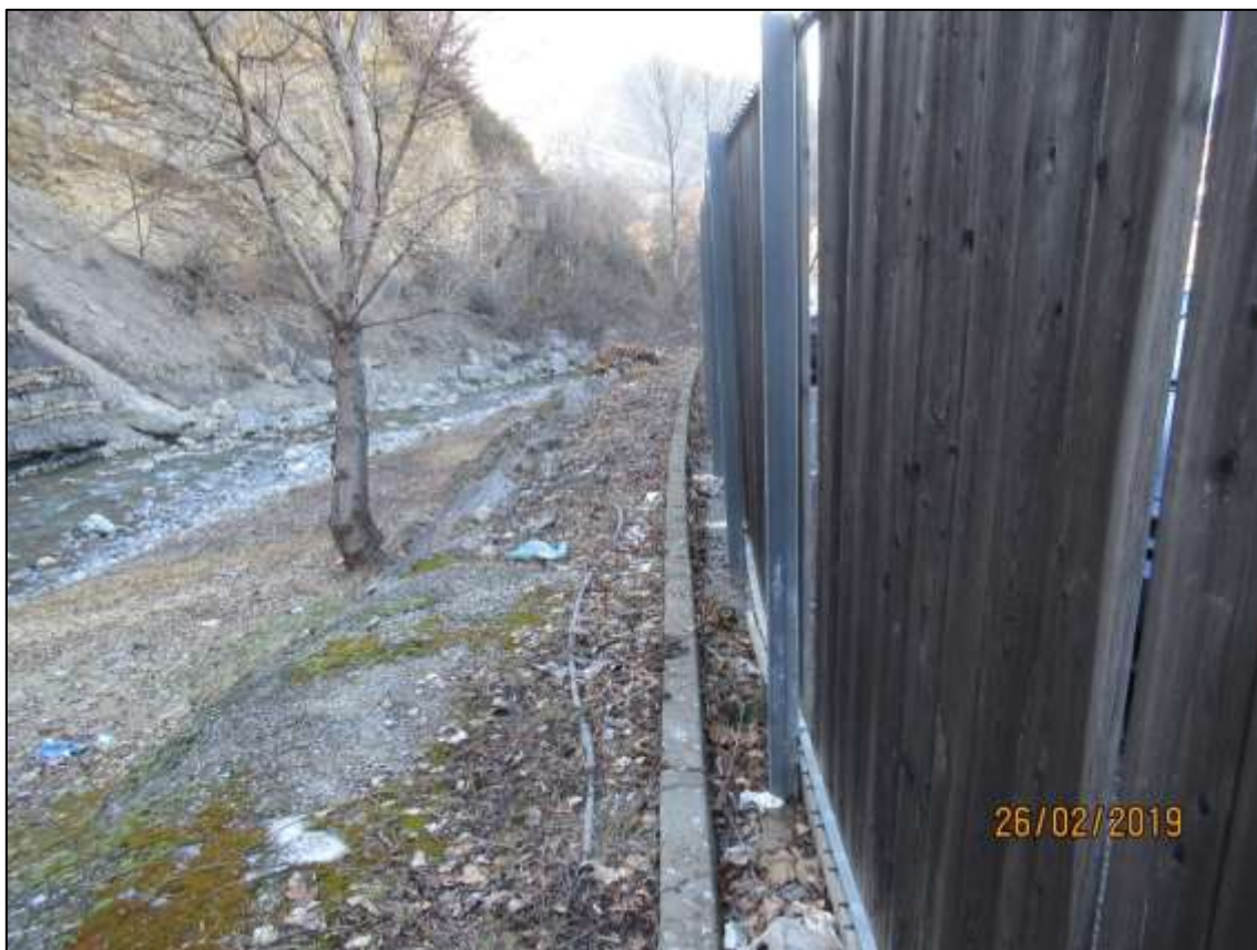
Figure 16 : Tronçon A, vue vers l’aval
