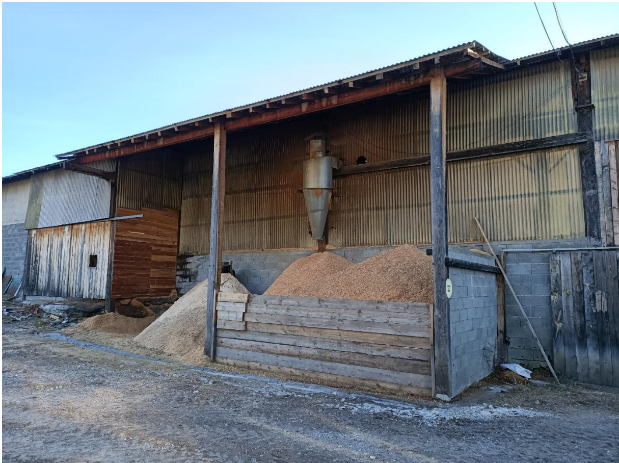
Figure 2. Zone de stockage façade Ouest (parois nécessitant d'être davantage fermées)
