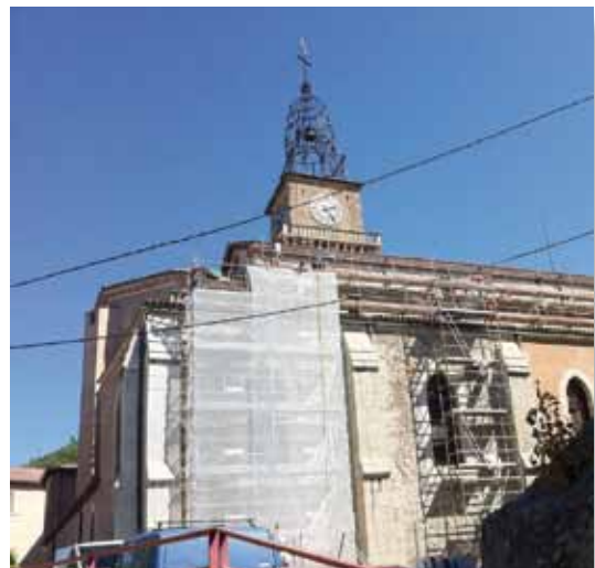
▲ Réhabilitation des façades de la Cathédrale Saint-Jérôme à Digne-les-Bains
