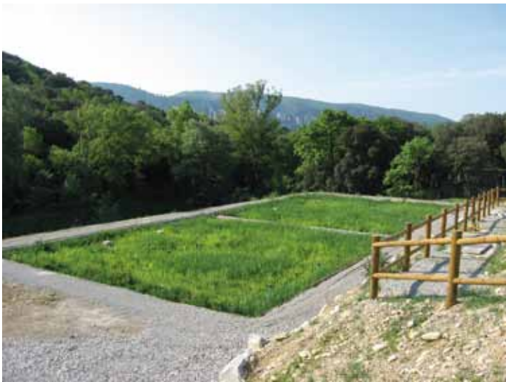
▲ Station d'épuration sur lit de roseaux
