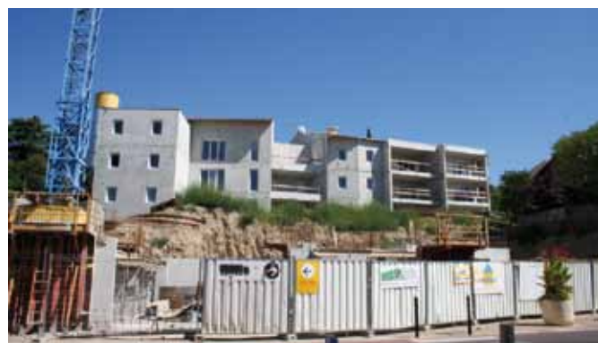
▲ Programme de construction les patios de Jade à Manosque (41 logements)
